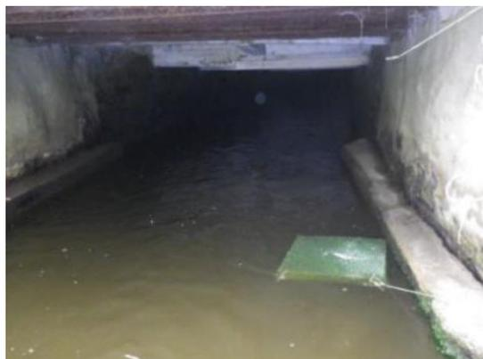
Figure 18: Flottang placé en amont immédiat des clapets du Loc'h (FDPPMA, 2018)
