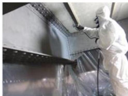
Décapage et remise en peinture de la structure métallique
