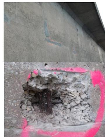
Travaux de nettoyage et de réparation des pieds de béquille rive droite et rive gauche : en cours
