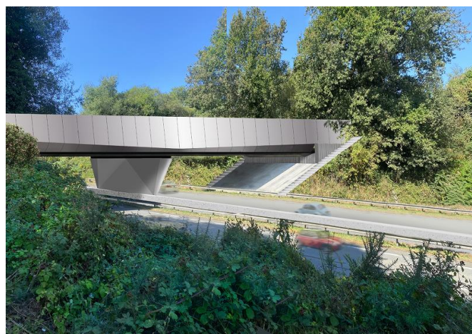
Le passage supérieur de St Joseph, la corniche s'étend en hauteur pour former le chiroptéroduct
