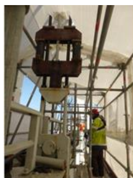
Test préalable au changement des suspentes
