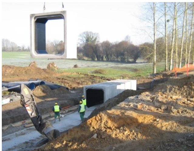
Phase 1 : le passage est assemblé.
