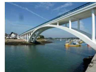
Figure 5 : Le pont de Kerisper reliant les communes de La Trinité-sur-Mer à Saint-Philibert.
