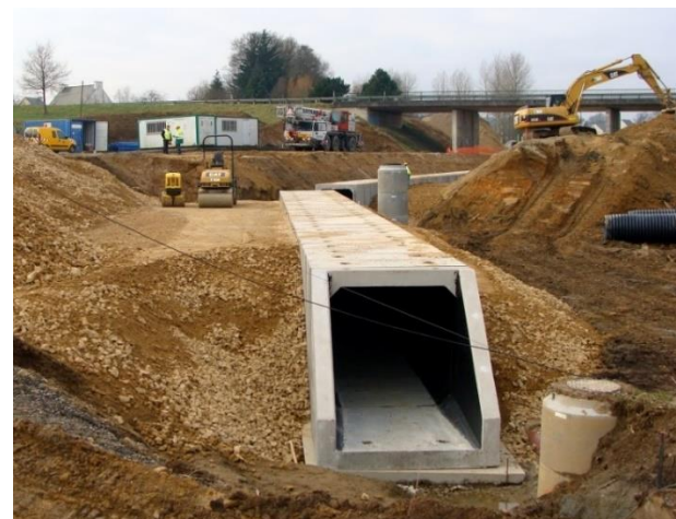
Phase 2 : Une fois assemblé, le passage est recouvert. .
